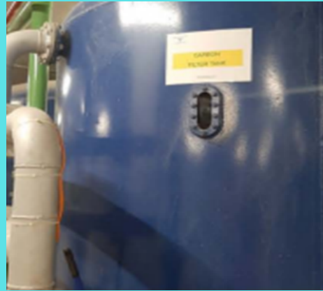
ถังดักไขมัน บ่อพักน้ำเสีย
