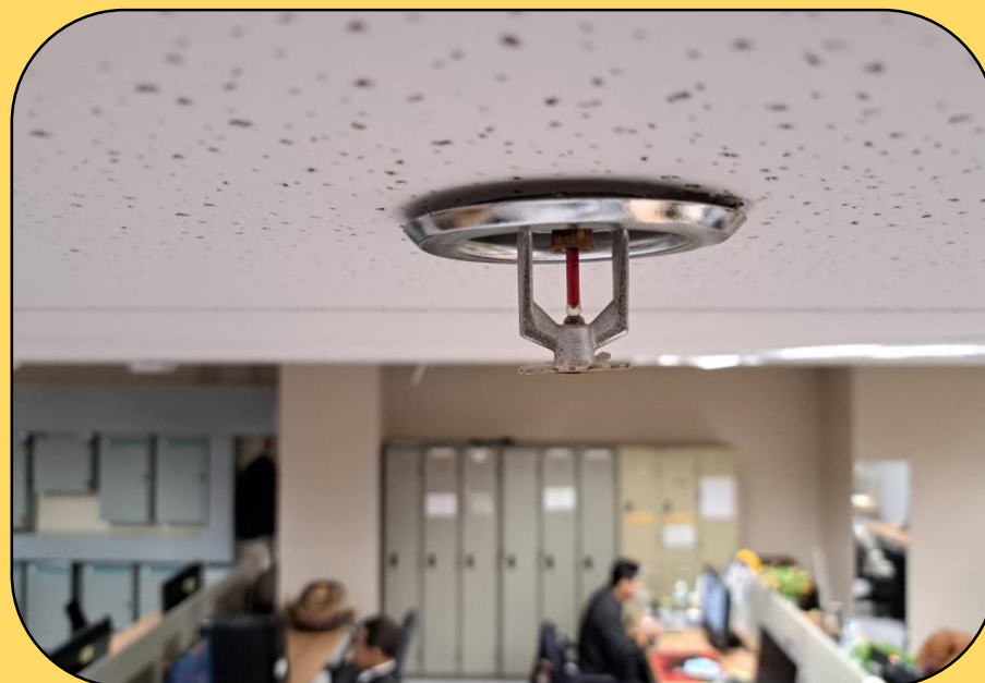
Fire Sprinkler: อุปกรณ์ที่ติดตั้งตามฝ้าเพดานภายในอาคาร จะทำงานอัตโนมัติเมื่อเกิดเพลิงไหม้ โดยอุณหภูมิภายในห้องจะสูงขึ้นทำให้แอลกอฮอล์ในกระเปาะแก้วขยายตัวจนแตก เปิดทางให้น้ำฉีดออกมาเป็นฝอยเพื่อควบคุมเพลิงไม่ให้ลุกลาม
