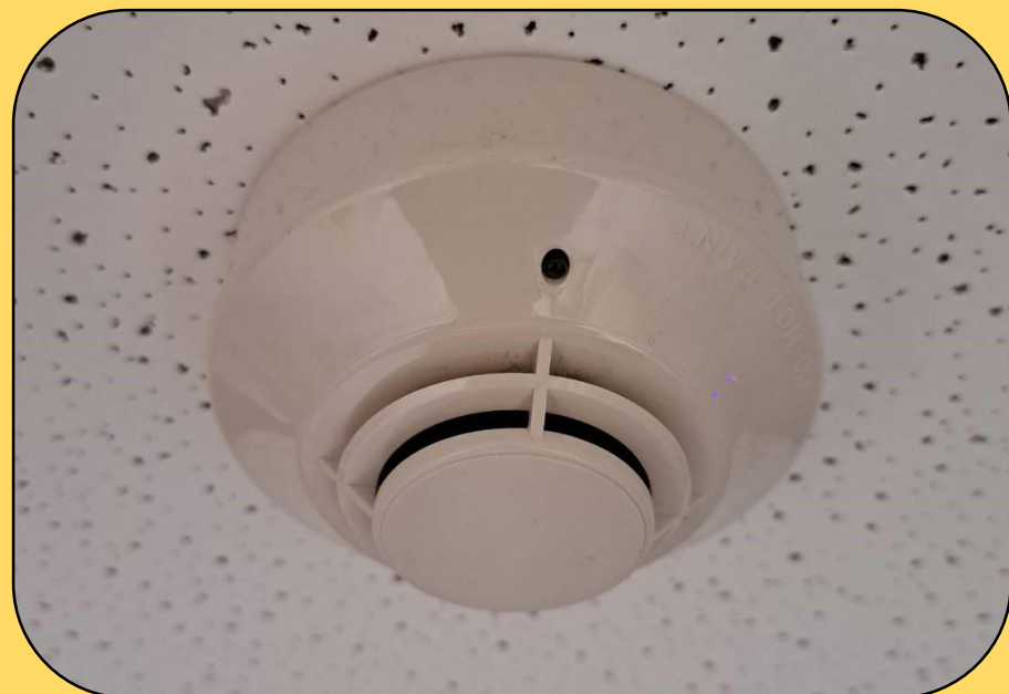
Smoke detector: อุปกรณ์ตรวจจับควัน โดยปกติหากเกิดเพลิงไหม้จะเกิดควันก่อน ทำให้สามารถตรวจจับเพลิงไหม้ในระยะแรกได้ทันทีและรวดเร็ว
