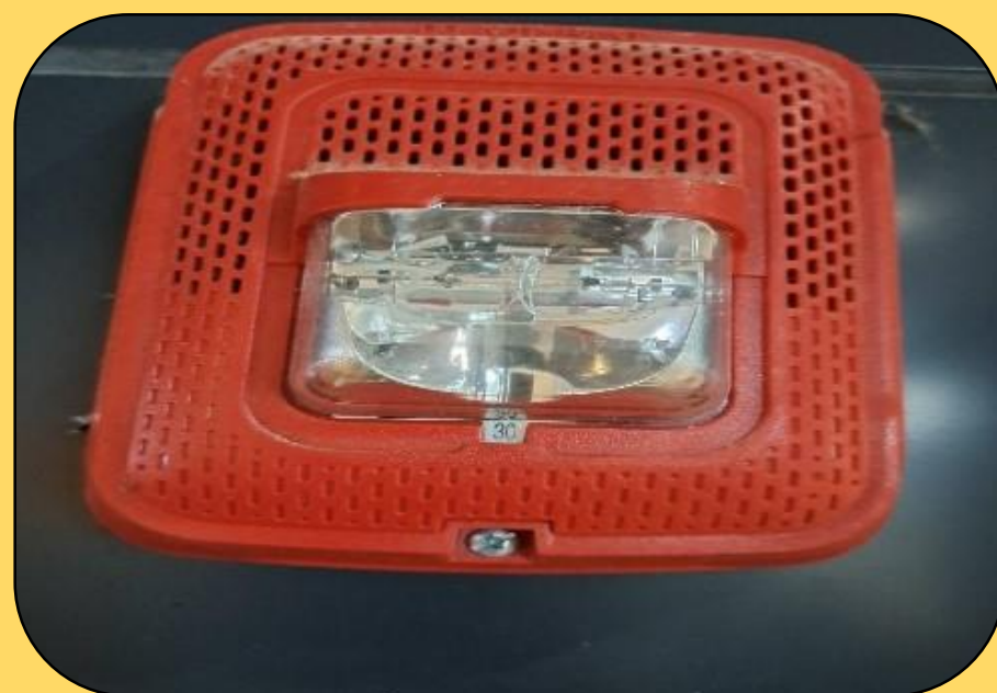
Horn strobe: อุปกรณ์แจ้งเหตุด้วยเสียงและแสงแฟลช
