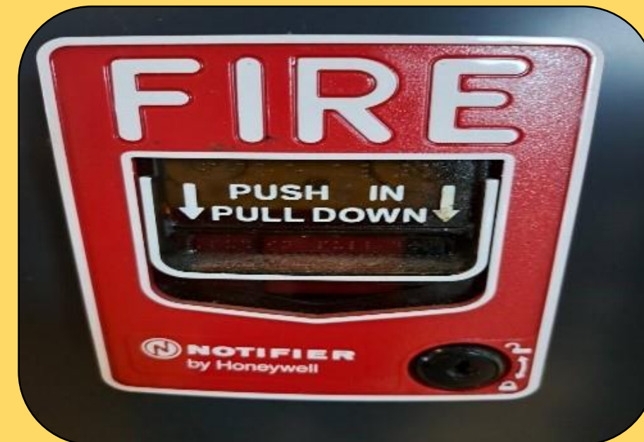
Manual pull station: อุปกรณ์แจ้งเหตุด้วยมือ เป็นอุปกรณ์เริ่มสัญญาณที่ทำงานโดยอาศัยการกระตุ้นจากบุคคล โดยกดและดึงหรือทุบให้แตก มีไว้สำหรับบุคคลที่พบเหตุสามารถแจ้งเหตุได้ทันที
