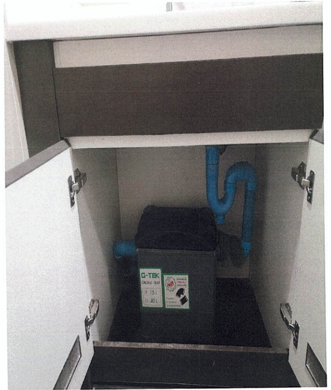
ตะแกรงดักเศษอาหาร และอุปกรณ์รองรับน้ำเสียบริเวณห้องเตรียมอาหาร (Pantry) ใกล้ห้องน้ำ
