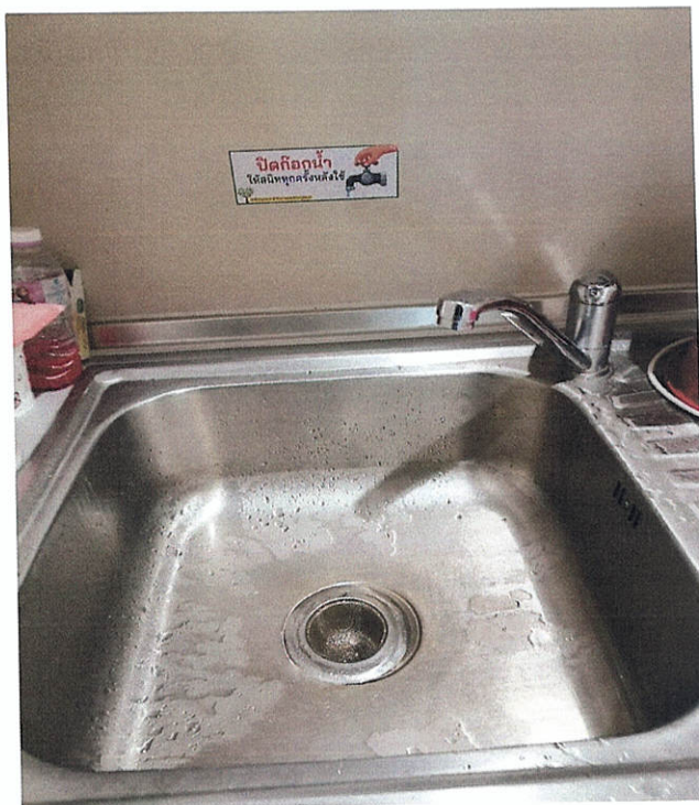
ตะแกรงดักเศษอาหาร และอุปกรณ์รองรับน้ำเสียบริเวณห้องเตรียมอาหาร (Pantry) ของสำนักกฎหมาย
