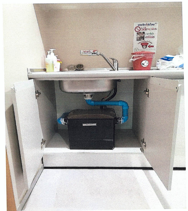
ตะแกรงดักเศษอาหาร และอุปกรณ์รองรับน้ำเสียบริเวณห้องเตรียมอาหาร (Pantry) ของสำนักกฎหมาย
