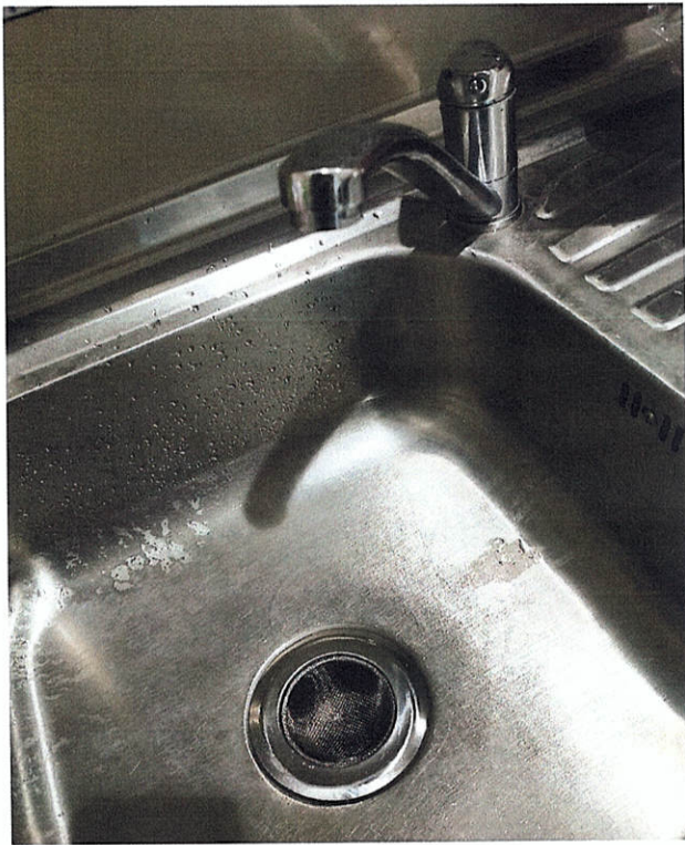
ตะแกรงดักเศษอาหาร และอุปกรณ์รองรับน้ำเสียบริเวณห้องเตรียมอาหาร (Pantry) ใกล้ห้องน้ำ
