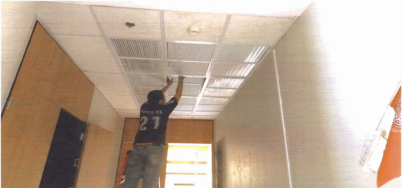
ภาพที่ ๔ ขั้นตอนการล้างทำความสะอาดตะแกรงช่องลมและหน้ากากพัดลมดูดอากาศ
