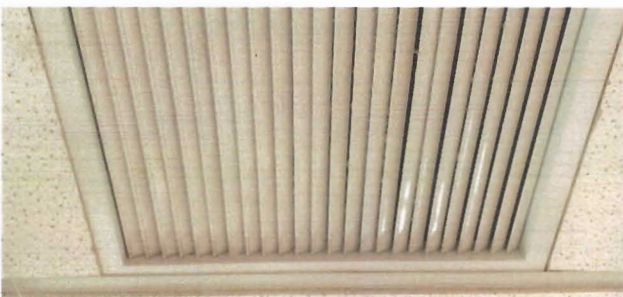
ภาพที่ ๓ ขั้นตอนการถอดแaggerงและหน้ากากพัดลมดูดอากาศ (ก่อนทำความสะอาด)
