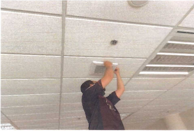
ภาพที่ ๒ ขั้นตอนการประกอบหน้ากากพัดลมดูดอากาศ (หลังทำความสะอาด)
