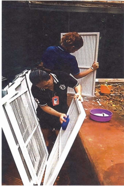
ภาพที่ ๔ ขั้นตอนการล้างทำความสะอาดตะแกรงช่องลมและหน้ากากพัดลมดูดอากาศ
