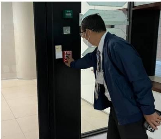
กดสัญญาณแจ้งเหตุฉุกเฉิน
