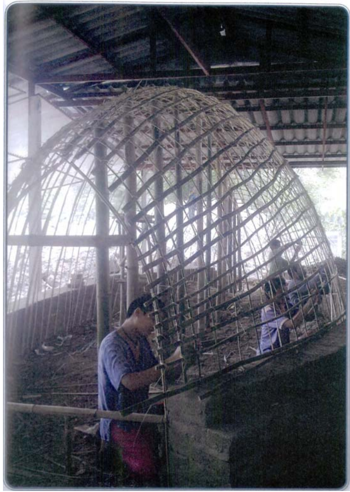
รูปที่ ๖-๕ การก่อตัวเตา และหลังคาเตา ด้วยโครงด้วยไม้ไผ่
