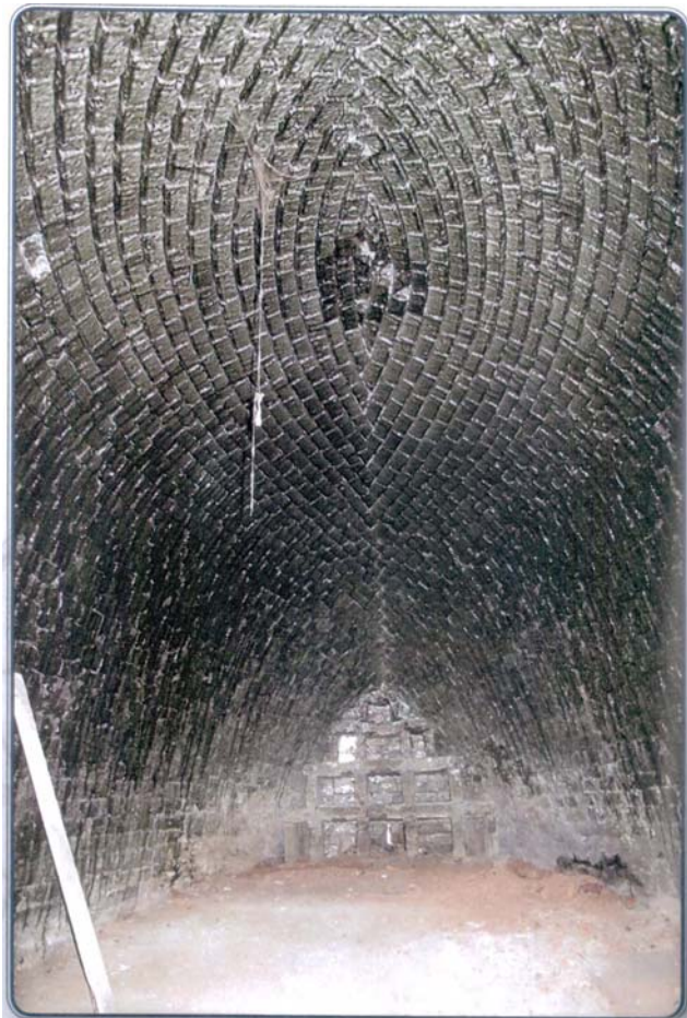
รูปที่ ๖-๑ การเรียงอิฐก่อหลังเตาหรือเพดานเตา และทำให้หลังเตามีความแข็งแรง
