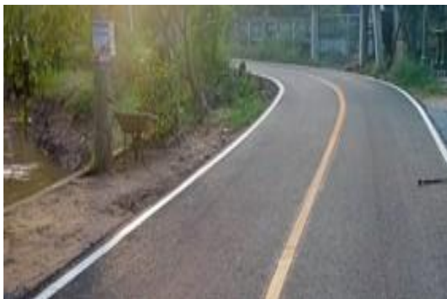
ติดตามโครงการปรับปรุงถนนคอนกรีตเสริมเหล็กเสริมผิวแอสฟัลท์ติก บ้านโพนสูง ตำบลหมื่นไวย อำเภอเมืองนครราชสีมา
