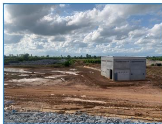
อาคารท่อระบายน้ำฝั่งขวาที่ก่อสร้างแล้วเสร็จ
