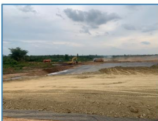
ปฏิบัติงานปูแผ่นดินเหนียวสังเคราะห์
