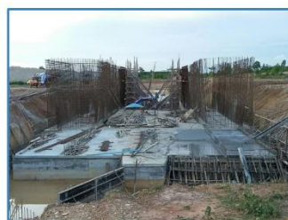
ปฏิบัติงานก่อสร้างอาคารระบายน้ำสัน
