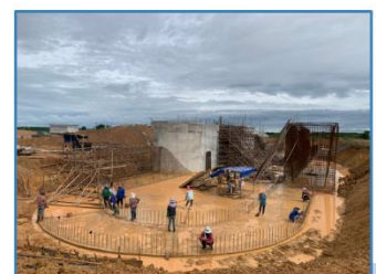
ปฏิบัติงานก่อสร้างอาคารระบายน้ำสัน
