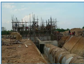
ปฏิบัติงานก่อสร้างอาคารท่อระบายน้ำฝั่งขวา
