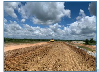
ปฏิบัติงานถมบดอัดตัวทำนบดิน
