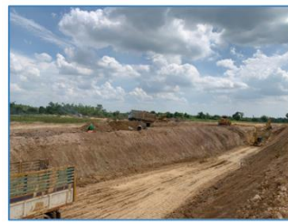
ปฏิบัติงานถมบดอัดร่องแนวทำนบดิน
