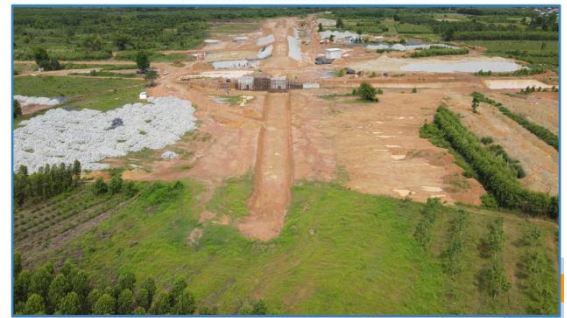
ภาพถ่ายขณะดำเนินการ
