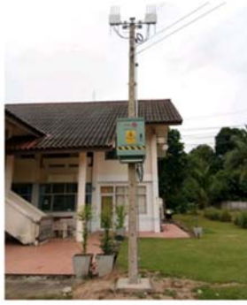
ภาพที่ ๔.๘ ตัวอย่างชุดอุปกรณ์กระจายสัญญาณของ Wi-Fi รพ.ต. ที่มา เอกสารประกอบการบรรยายโดย รศ.ดร.ชัยวัฒน์ อดตมากร
