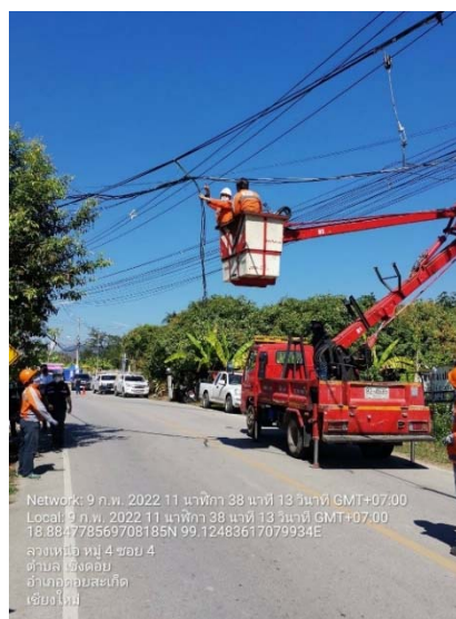
ภาพที่ ๑๒ การแก้ไขปัญหาปัญหาสายสื่อสารที่ไม่ได้ใช้งาน (สายตาย) และสายสื่อสาร ที่เป็นเหตุให้เกิดเพลิงไหม้ ในพื้นที่หมู่ ๔ และหมู่ ๕ ตำบลหลวงเหนือ อำเภอดอยสะเก็ด จังหวัดเชียงใหม่
